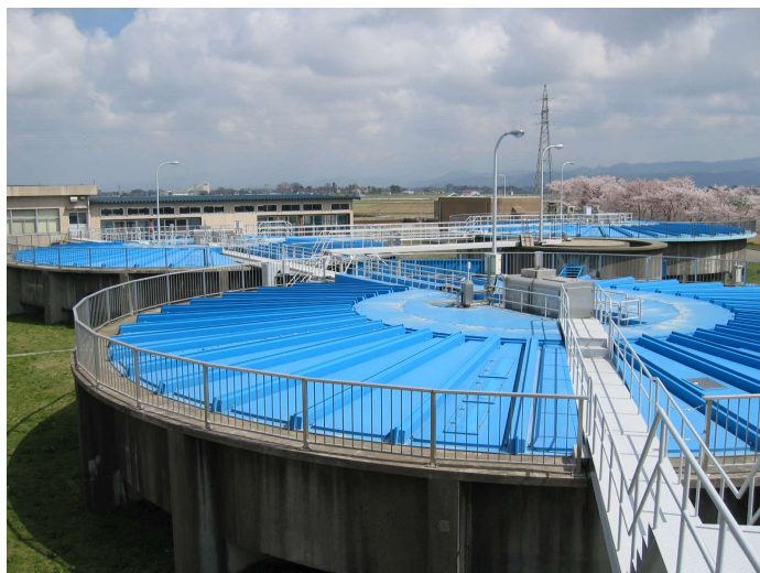
小牧浄水場 高速沈でん池
